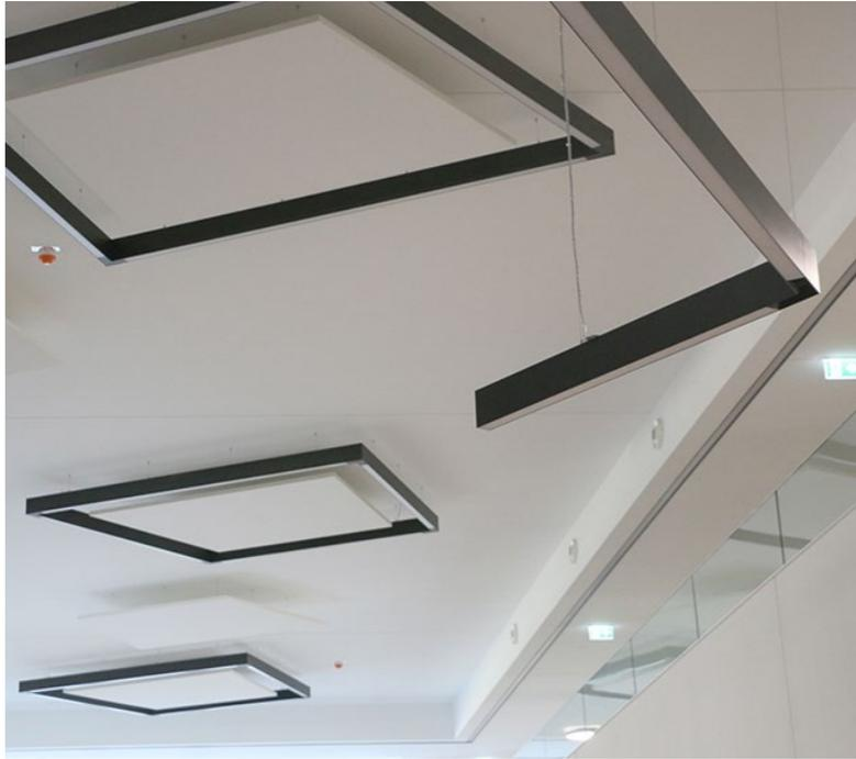
Unser Beleuchtungskonzept mit LED-Beleuchtung wird tageslicht- und zonenabhängig gesteuert.
