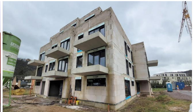
Bautenstand Gebäude A im Februar 2024
